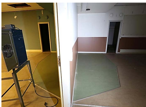
Igensatt golv vid f.d. HC/verkskyddC (med vägg)
