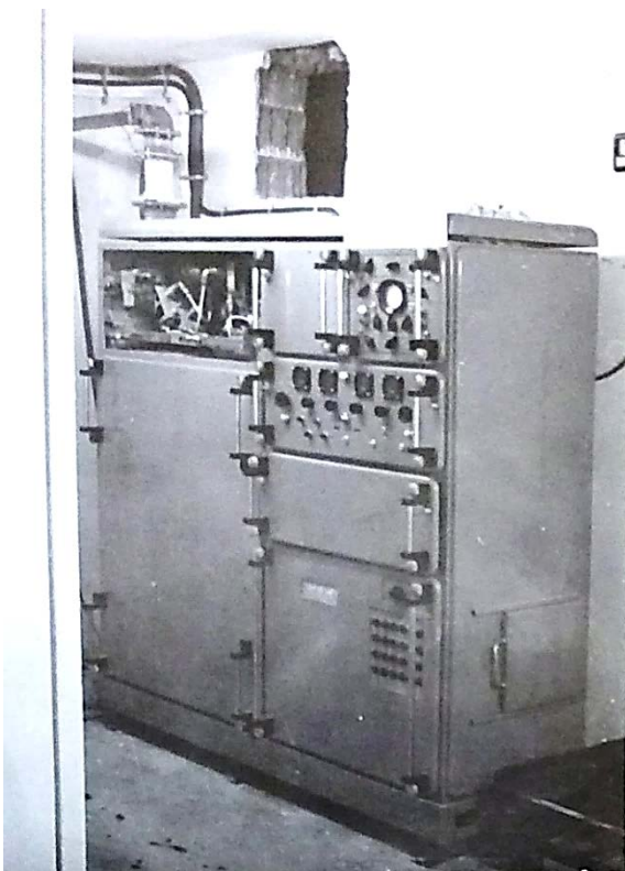
S/M stativ i radarrummet
